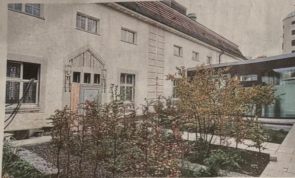
Im Badehaus 2 wird noch gearbeitet. Bald wird das historische mit dem modernen Bauwerk endgültig verbunden, was eine Erweiterung der »Sprudelhof Therme« bedeutet.
